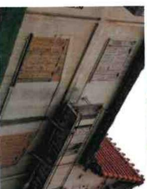
Les **balcons isolés** au nord sont d'origine. Au sud, les **verrières** rajoutées rapidement dans l'évolution de la Villa ont permis de mettre hors d'eau les tourelles, et de prolonger hors d'eau la cage d'escalier à R+3. D'un côté, ce sont des ouvrages légers, pas intéressants dans l'évolution du bâtiment, de l'autre, ces volumes masquent les façades en pignons.
