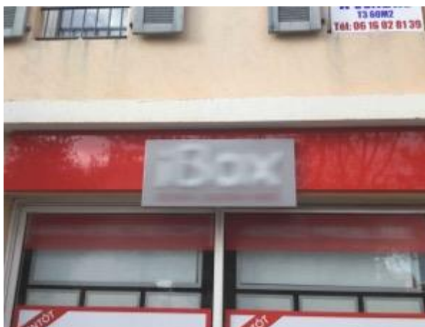
Enseigne lumineuse éclairée par transparence, novembre 2018 - Sanary-sur-Mer
