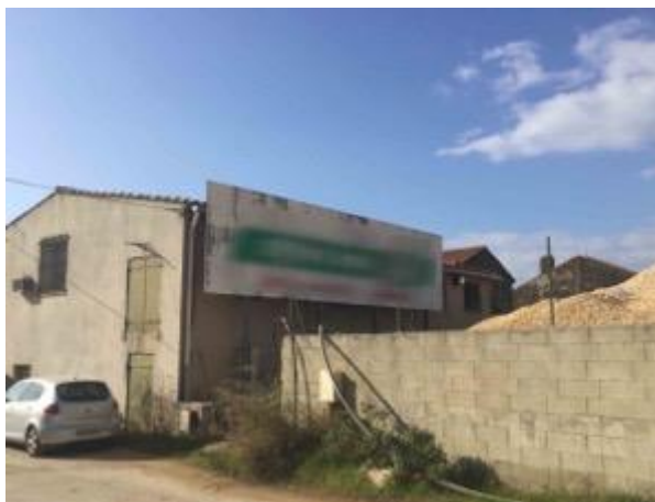
Enseigne sur panneau de fond en infraction : dépasse le mur, novembre 2018 - Sanary-sur-Mer
