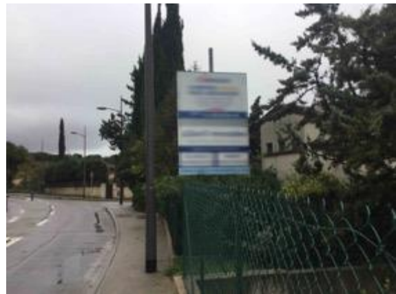
Dispositifs scellés au sol de petit format ne respectant pas la règle de H/2 - novembre 2018 route de Bandol – Sanary-sur-Mer
