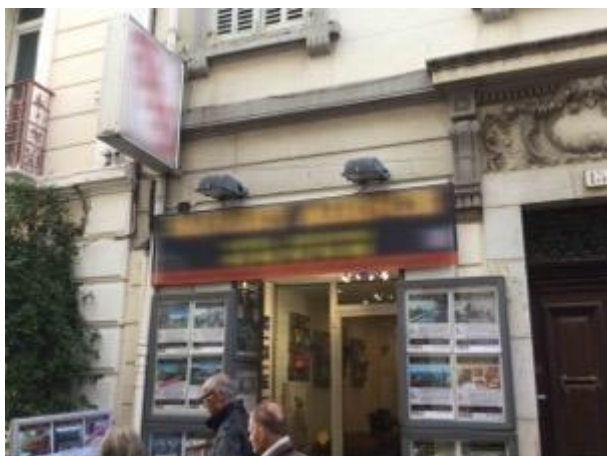
Façade saturée d'enseigne, novembre 2018 - Sanary-sur-Mer
