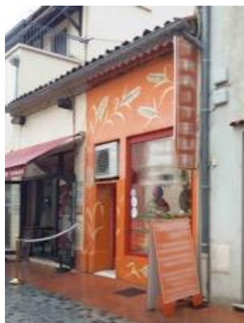
Façade marquante, novembre 2018 - Sanary-sur-Mer
