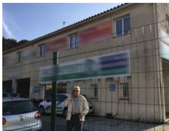
Enseignes parallèles sur panneau de fond disposées entre chaque ouverture de premier étage, novembre 2018 - Sanary-sur-Mer
