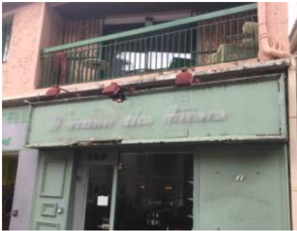
Enseigne en mauvais état d'entretien, novembre 2018 - Sanary-sur-Mer
