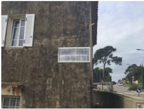
Dispositif apposé au mur de petit format en infraction : le mur n'est pas aveugle - ancien chemin de Toulon – novembre 2018 – Sanary-sur-Mer
