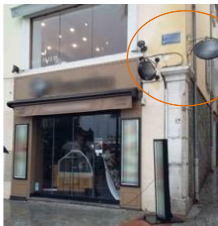
Enseignes perpendiculaires disposées de chaque côté des voies bordant l'activité, novembre 2018 - Sanary- sur-Mer
