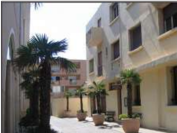
Quartier de la Médiathèque
