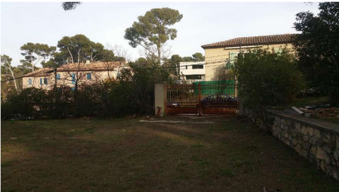
Accès véhicule central
