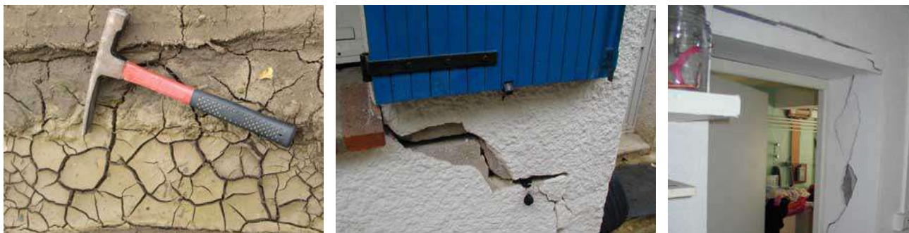
Illustrations du phénomène de retrait gonflement des argiles (source http://www.argiles.fr/ )
