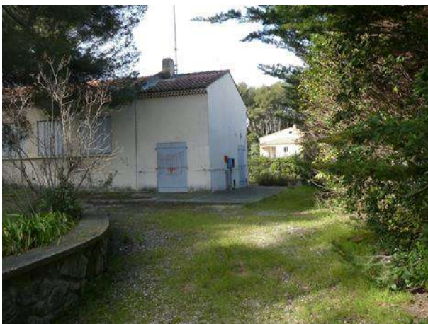
Sol en stabilisé et espace de circulation autour du bâtiment annexe en L
