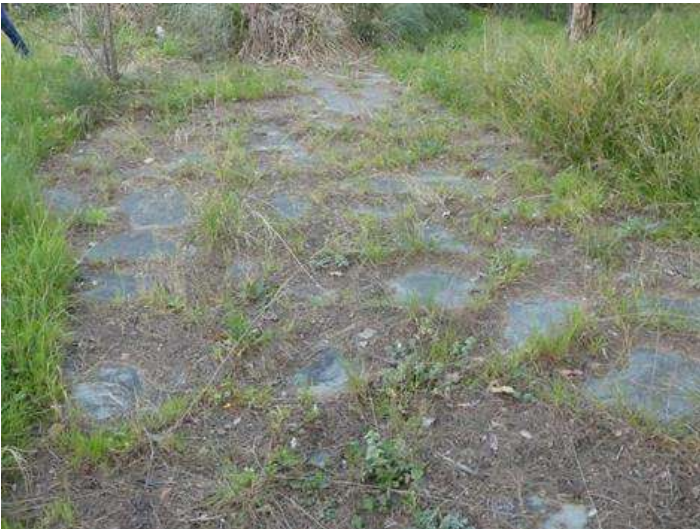
Dalle support de la piscine
