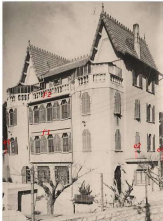
Fig. 20 – Elévation Sud avec extension par adjonctions en e1 et e2 et avancée de façade du corps principal en f1 et sa balustrade en f2.
