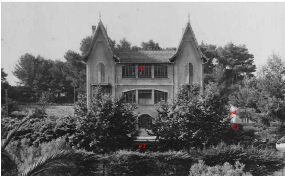
Fig. 24 – Élévation Nord avec extension par adjonctions en e1 et e3, et construction d'une aile plus au Sud en e4.
