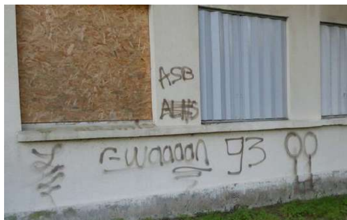
Bâtiment annexe en L
