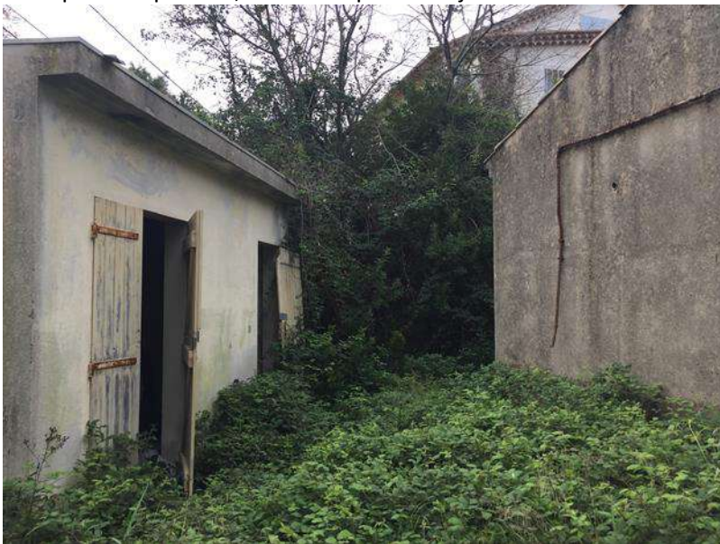
Roncier entre la maison murée et sa dépendance
