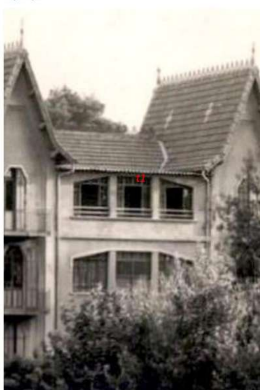
Fig. 18 – Détail élévation Nord avec extension et toiture rapportée en t1.
