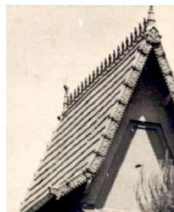
Fig. 16 – Détails des éléments décoratifs en toitures.
