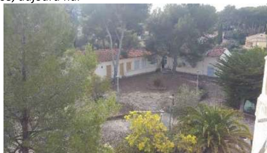
Bâtiment annexe en L
