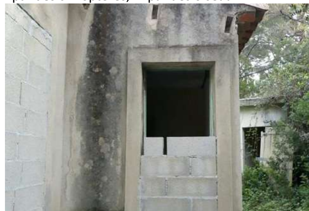
Ouverture partiellement murée.
