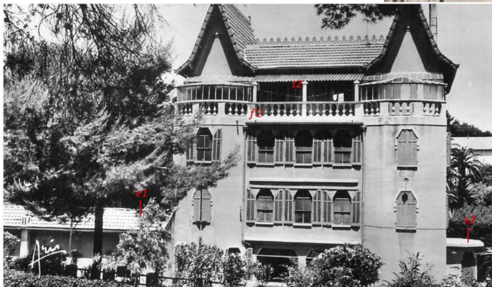
Fig. 22 – Elévation Sud avec extension par adjonctions en e1 et e2 et avancée de toiture sur colonnes en t2.
