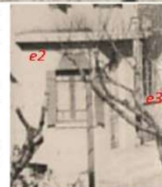
Fig. 21 – Ci-contre un extrait permettant de percevoir l'extension e3 en façade Nord
